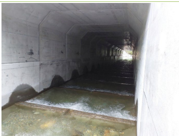
FIGURE 5 : ESCALIERS ET SUBSTRAT ROCHEUX À L'INTÉRIEUR DU PONCEAU MODIFIÉ DU CHEMIN RÉAL (CÔTÉ EST)
