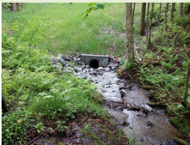
FIGURE 9 : CAMÉRA 7 – PONCEAU TÉMOIN DU CHEMIN DE LA VALLÉE-MISSISQUOI (CÔTÉ OUEST)
