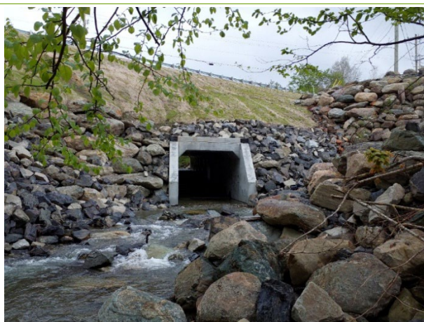
FIGURE 6 : CAMÉRA 4 – PONCEAU MODIFIÉ DU CHEMIN RÉAL (CÔTÉ OUEST)
