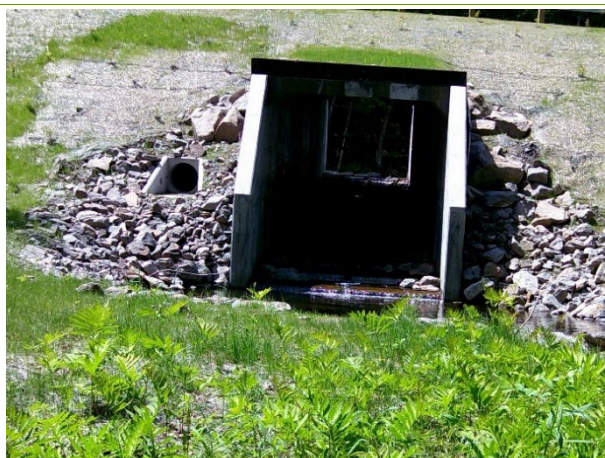
FIGURE 8 : CAMÉRA 6 – PONCEAU MODIFIÉ DU CHEMIN DE LA VALLÉE-MISSISQUOI (CÔTÉ EST)
