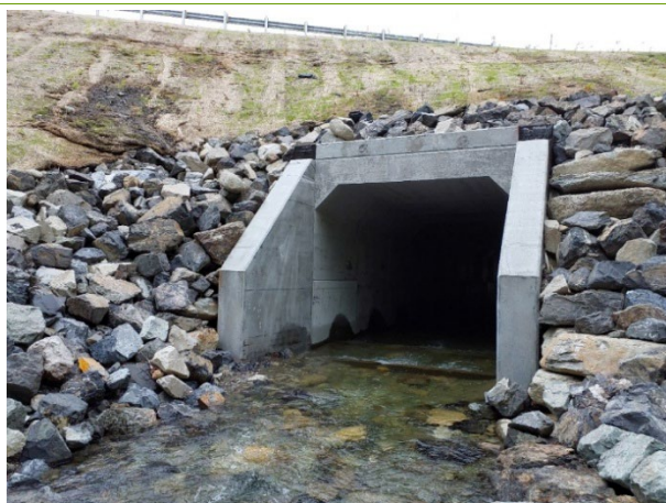
FIGURE 4 : CAMÉRA 3 – PONCEAU MODIFIÉ DU CHEMIN RÉAL (CÔTÉ EST)
