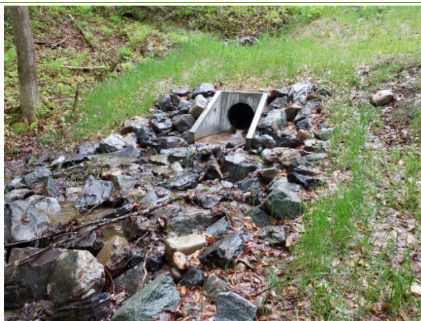
FIGURE 10 : CAMÉRA 8 – PONCEAU TÉMOIN DU CHEMIN DE LA VALLÉE-MISSISQUOI (CÔTÉ EST)
