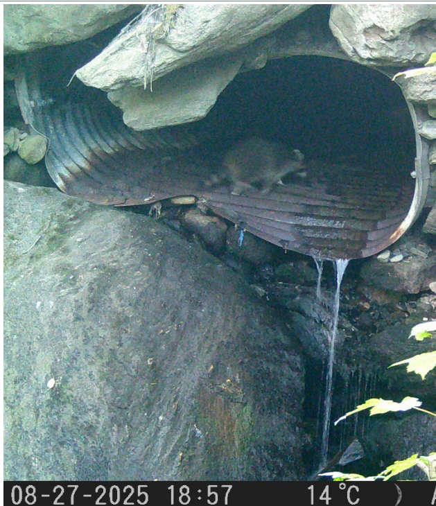
FIGURE 13 : RATON LAVEUR DANS L'ENTRÉE DU PONCEAU TÉMOIN DU CHEMIN RÉAL (CAMÉRA 2)
