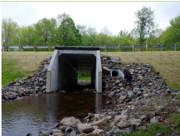
FIGURE 7 : CAMÉRA 5 – PONCEAU MODIFIÉ DU CHEMIN DE LA VALLÉE-MISSISQUOI (CÔTÉ OUEST)
