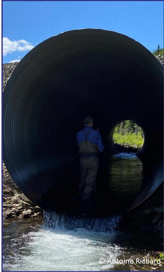
Caractérisation des ponceaux
